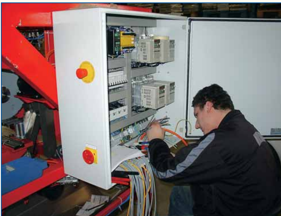
Tachtig procent van de werkzaamheden van VGB bestaat uit engineering en softwareontwikkeling, de overige twintig uit paneelbouw en afwerking.
